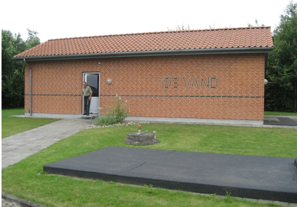
Figur 1: Øster Snede Vandværk. Foto fra tilsyn i 2010.
